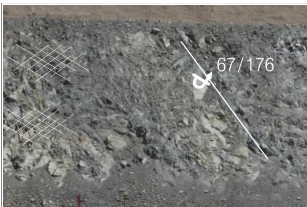
【그림 24】 D 영역에 발달한 불연속면
