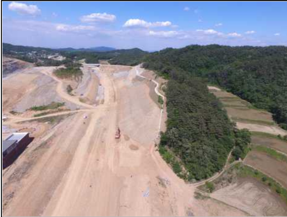
【그림 3】 깎기비탈면 시점부 측면 사진
