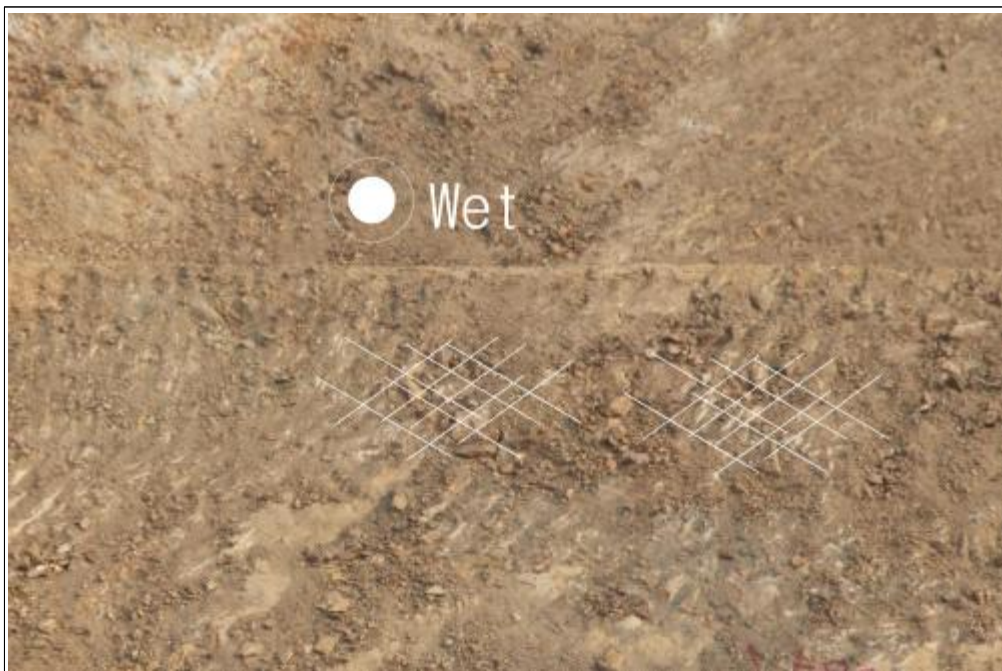
【그림 29】 E 영역 상세사진 (세편화된 암석 및 지하수 유출)
