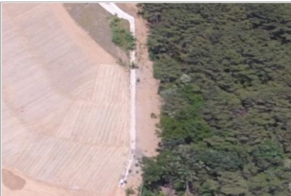
【그림 8】 산마루배수구 설치
