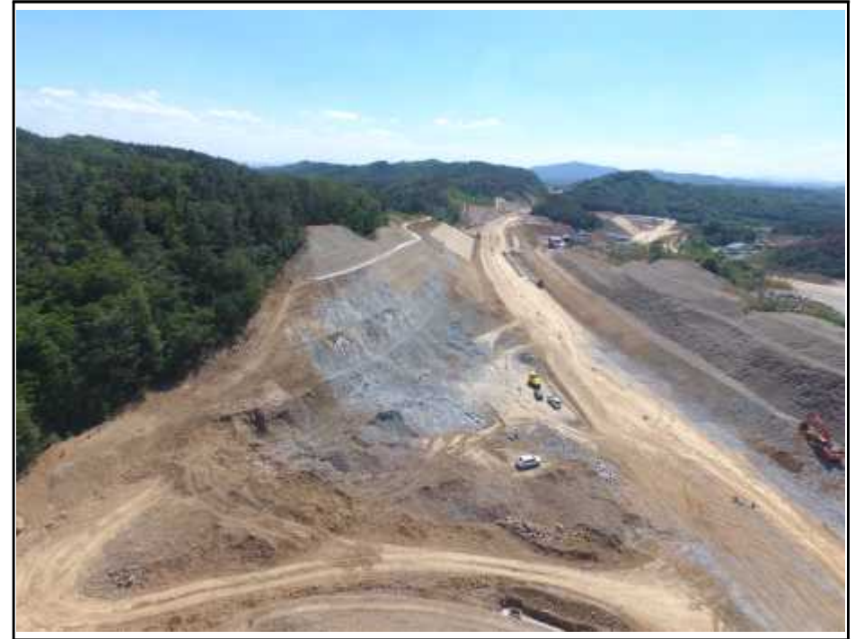
【그림 4】 깎기비탈면 종점부 측면 사진
