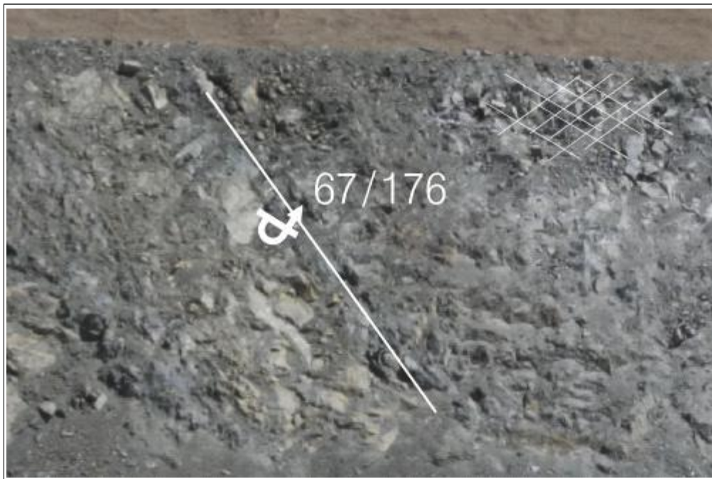
【그림 23】 D 영역에 발달한 불연속면
