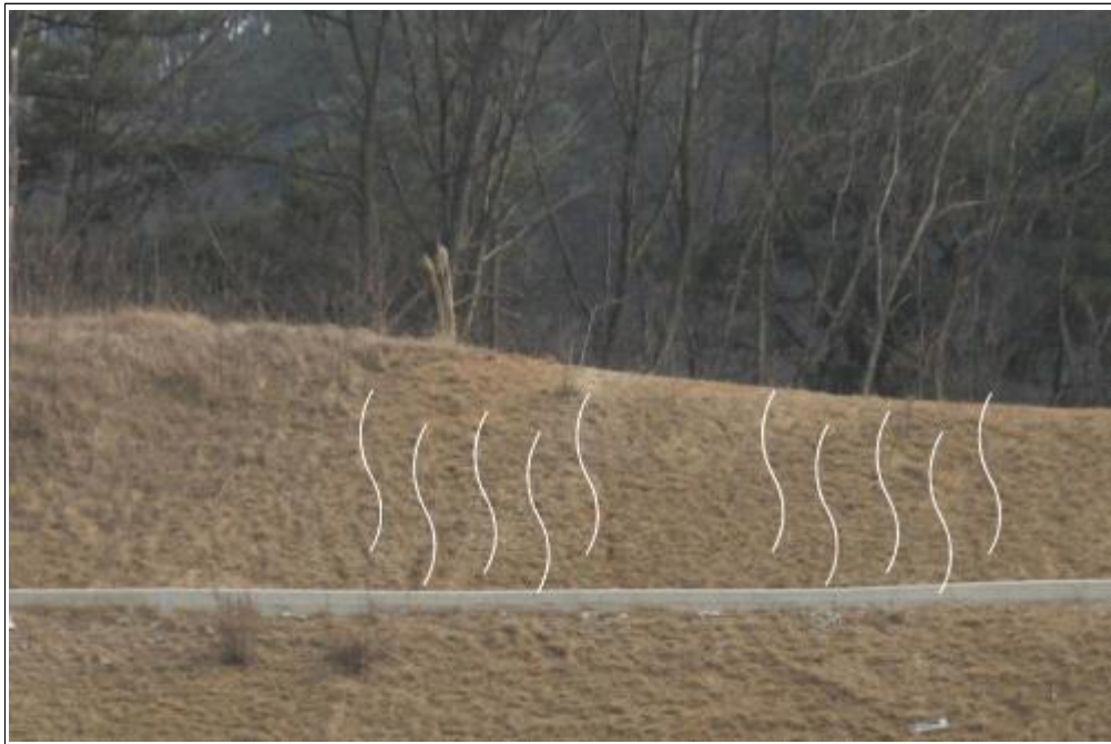
【그림 33】 G 영역 상세사진 (토사유실 및 우류침식)
