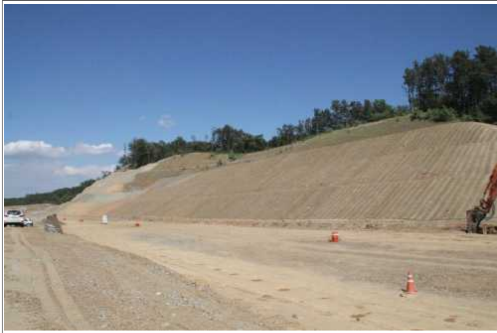
【그림 34】 G 영역 상세사진 (압성토 시공)
